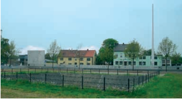
Löschwasserteich des Männerlagers. Im Hintergrund die Stele von 1947 und die Rückansicht der Neugestaltung der Gedenkstätte Neue Breim
