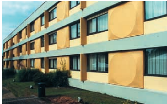
Das 1975 errichtete Hotel auf dem Gelände des Frauenlagers
