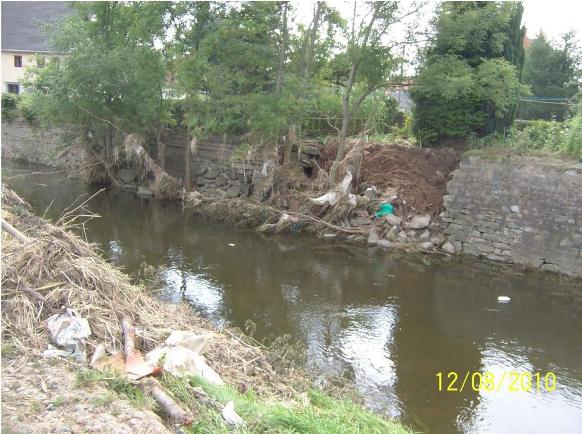
Bild: Beim Hochwasser 2010 beschädigte Ufermauer in der Lausitz
