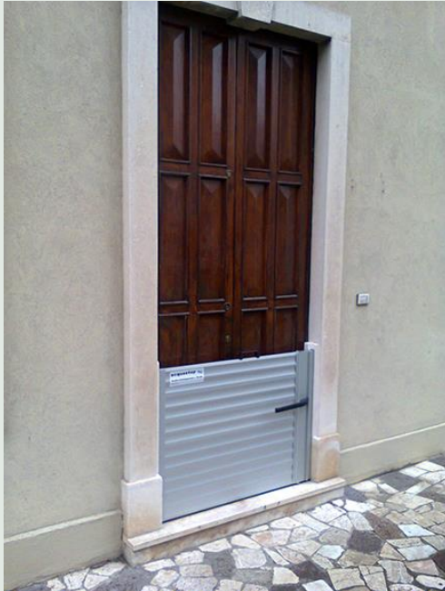
Flutschott manuell, Quelle: O. Koch
