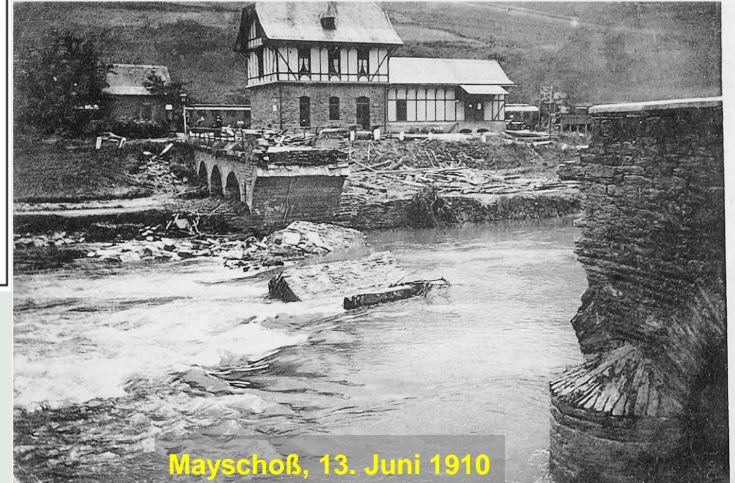
Wetterkatastrophe im Ahrtal am 13. Juni 1910. Zerstörte Strassenbrücke in Mayschoß.
