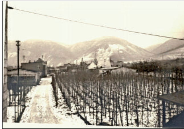
Die ehemaligen Baracken des KZ-Außenlagers Cochem in Bruttig, Auf der Kipp (um 1960). Quelle: : Manfred Ostermann
