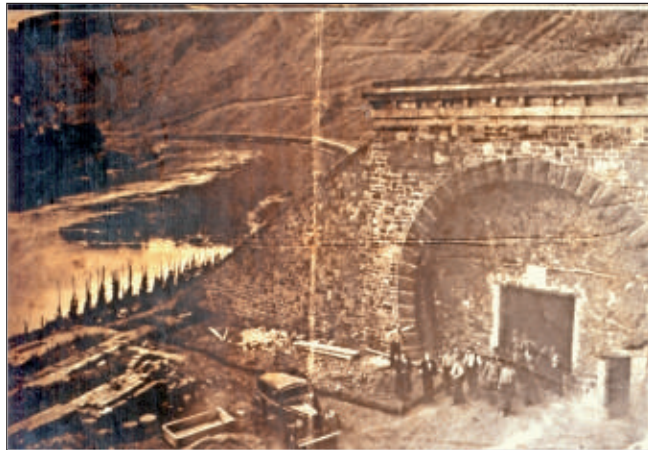
Tunneleingang von der Bruttiger Seite, noch vor dem Beginn der Arbeiten der KZ-Häftlinge (Foto: Manfred Ostermann)
