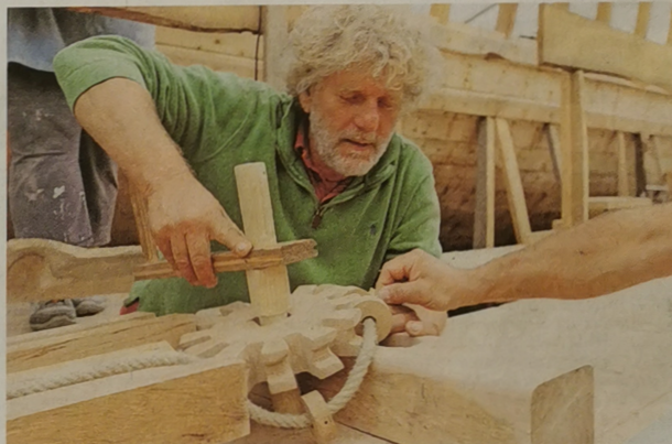
Roland Schons aus Luxemburg gehört zu den 50 Mitwirkenden des Projekts. Er baut aus Holz eine römische Bilgepumpe für das Schiff. Damit wurde um das Jahr 300 n. Chr. Wasser aus dem Rumpf befördert.
