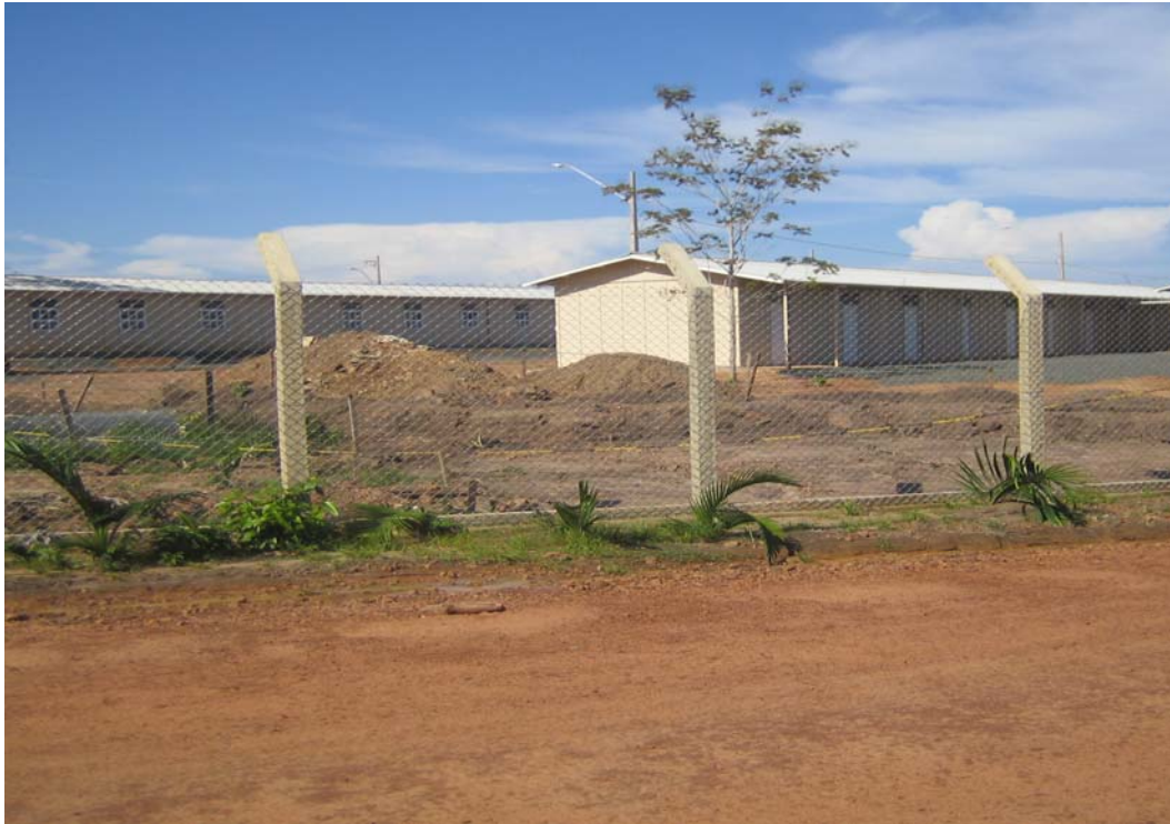
Abbildung 7: Juruti Novo, im Bau befindliche Wohnungen und Büroräume der OMNIA Minérios
