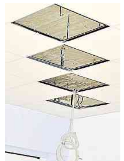
Die Seminarraumdecke wurde erneuert und Wasserleitungen in den Zwischenräumen verlegt.
