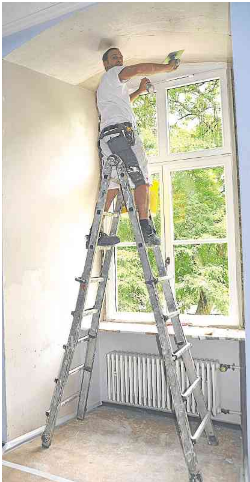
Neue Fenster für den Seminarraum: Mathias Grill (Firma Niesius, Hochstetten) verputzt die Fensterlaibungen.
