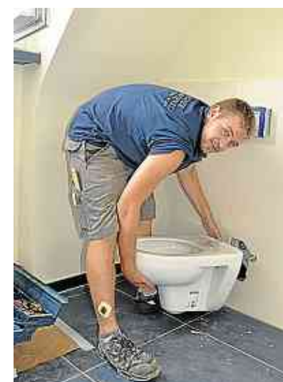
Pascal Möhler (Firma Wagner, Oberhausen) setzt in den neuen Doppelzimmern die Sanitärbecken.
