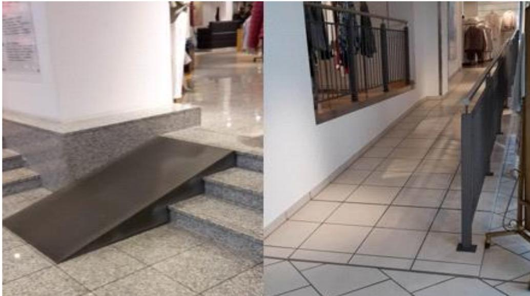
Abbildung 5.2: links: sehr steile Rampe ohne Handläufe sehr schmal, ohne Radabweiser im Vergleich
