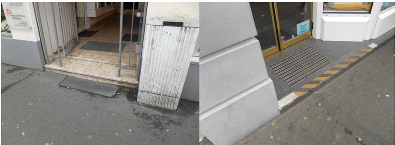
Abbildung 5.3: links: Stufen schlecht erkennbar; ohne Handläufe und rechts: Stufe mit Kontrastfeld,
