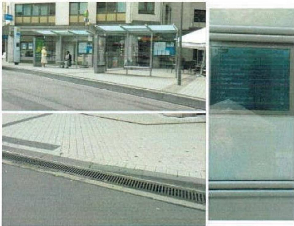
Abbildung 3.12: Haltestelle Treviris mit Bordsteinerhöhung (oben), Bordsteinabsenkung und Blindenleitsystem (unten) und dynamischer Fahrgastinformation (rechts) (Quelle: EIGENE FOTOGRAFIE)
