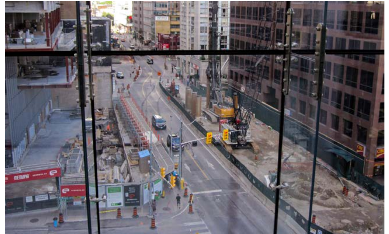
Baustelle mit Engpass in Downtown Toronto
