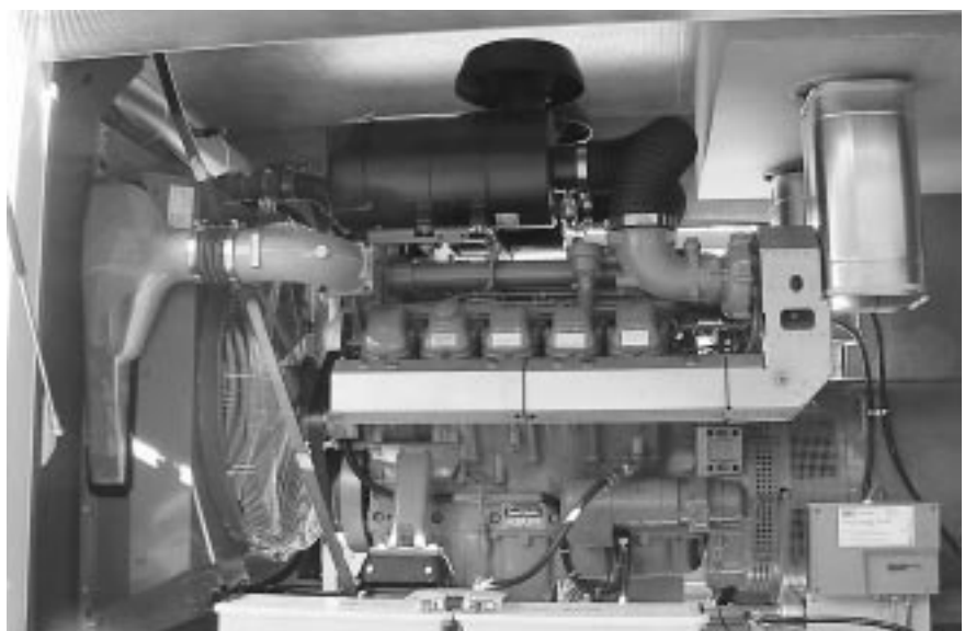
Blick auf das Herzstück des Aggregates der 500 kW starke Dieselmotor.
