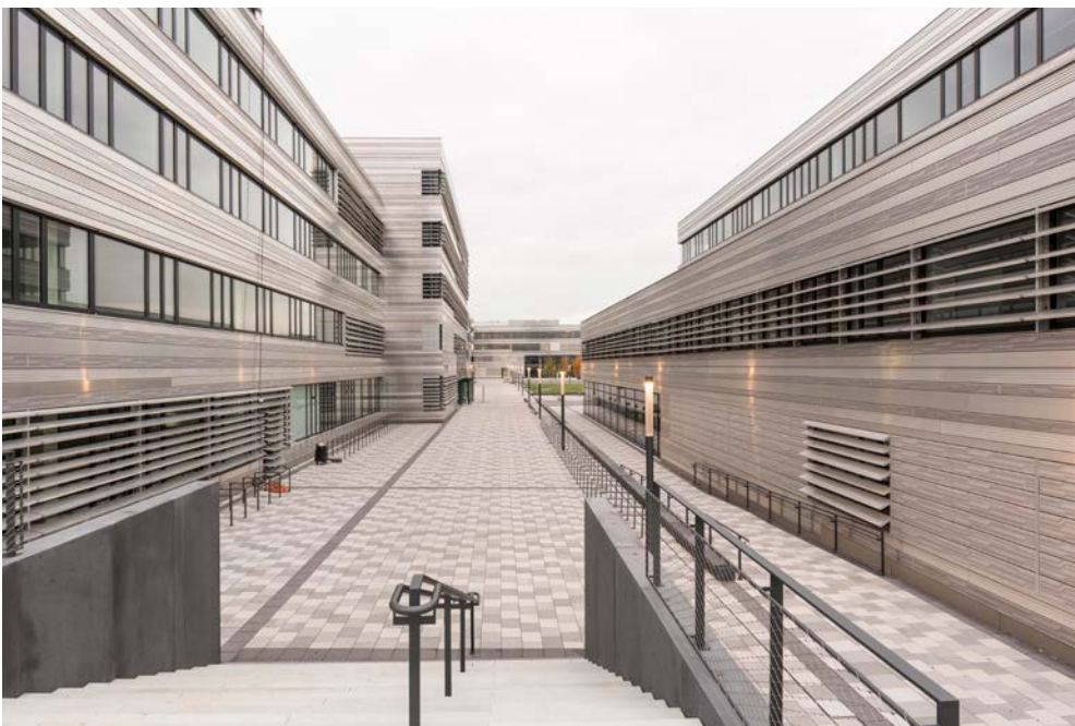
Abb. 5 Barrierefreie Zugangswege ermöglichen die Teilnahme für alle
