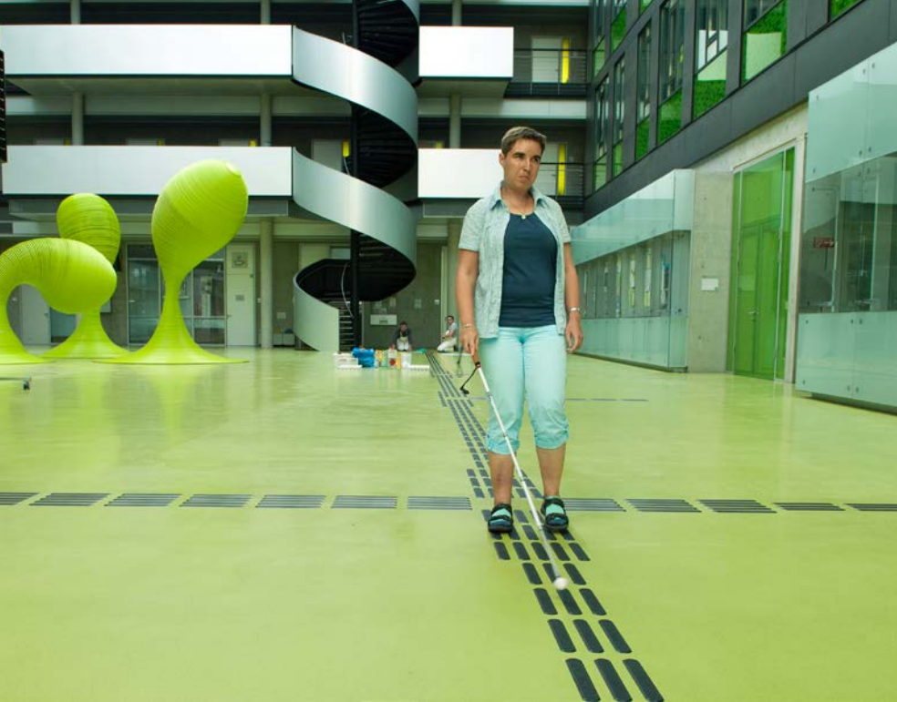
Abb. 13 Taktiler Leitsystem in einem Institutsgebäude
