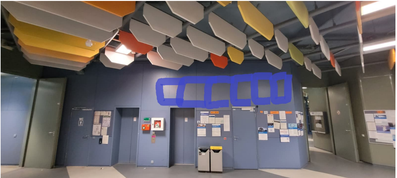
C-Gebäude bei den Aufzügen (6 Flächen)
