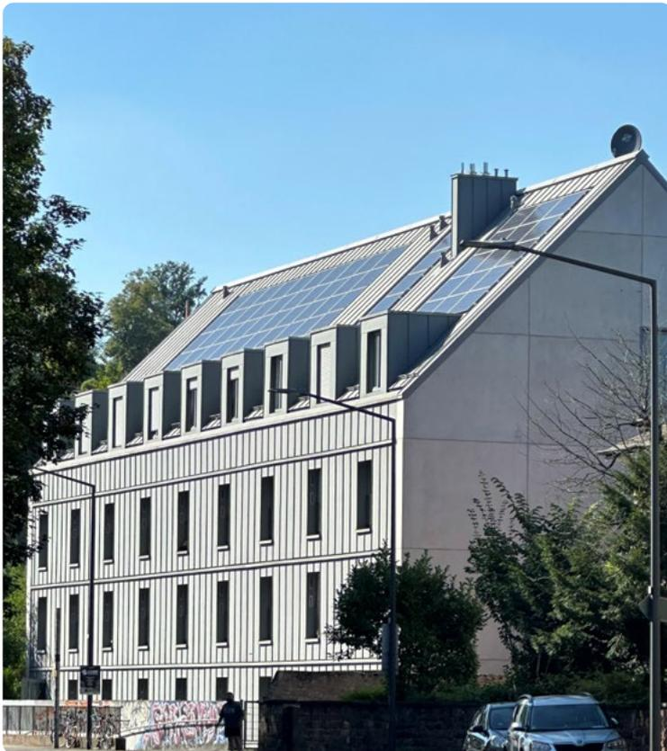
An der neuen Wohnanlage „Haus am Baum“ sind die Solarmodule direkt in die Dachflächen integriert. Das Dach und die Fassade bestehen aus vollständig recycelbarem Aluminium.
