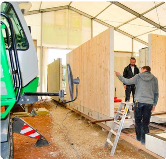
Der Einsatz von Photovoltaik und Luft-Wasser-Wärmepumpen ermöglicht einen Energiestandard noch unter KfW 40. In einer sogenannten „Feldfabrik“ wurden die angelieferten Fertigelemente der Firma LiWood aus München zu einzelnen Appartements montiert und anschließend an der Baustelle zum Gebäude gestapelt. Rund 375 Kubikmeter FSC-zertifiziertes Holz aus Österreich und Bayern wurden als nachwachsender Rohstoff verbaut.
