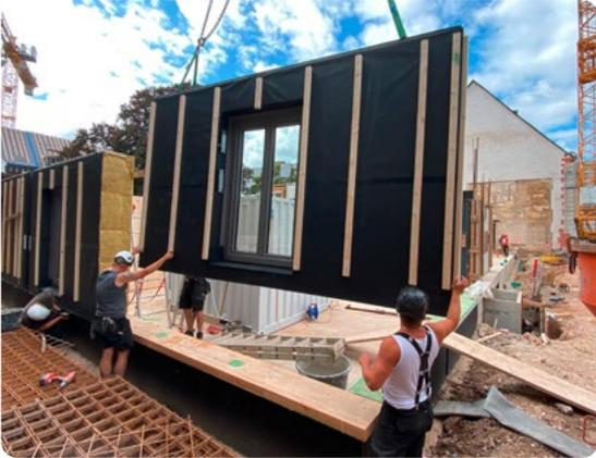
Auch beim „Haus am Baum“ wurden angelieferte Fertigelemente in der Holz-Hybrid-Bauweise direkt auf der Baustelle montiert.
